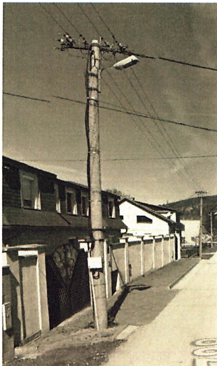
Obr. 3a, b Svietidlo VO na betónovom a oceľovom stožiar
