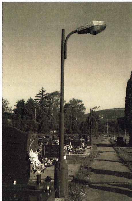
Obr. 3c, d Svietidlo VO na parkovom betónovom a parkovom oceľovom stožiaroch
